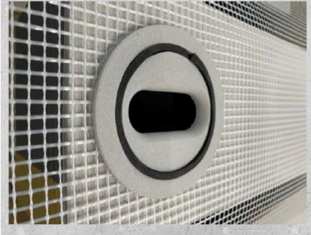
Abbildung 3: Gewebeabschluss eines Mauerseglerkastens der emv AG
