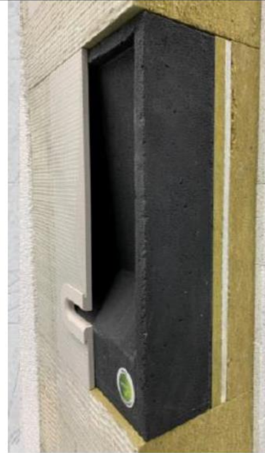
Abbildung 4: Fledermauskasten der emv AG mit Hochleistungsdaämmstoff auf Aerogelbasis (weiße Schicht)
