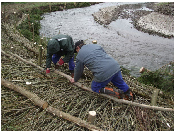
Foto 17: Mit Hilfe von Riegelhölzern und Drahtverbindungen werden die Äste im Böschungsbereich befestigt. (Foto: A. Stowasser)
