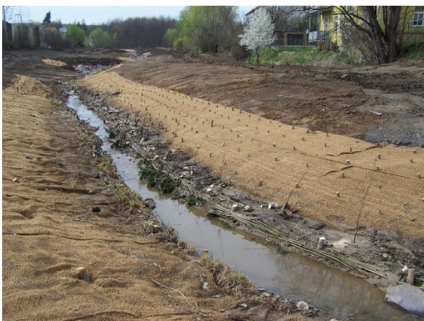
Foto 29: Lebendfaschinen sind leicht zu überreden, damit ein guter Bodenkontakt hergestellt wird und der Austrieb gewährleistet ist. (Foto: A. Stowasser)
