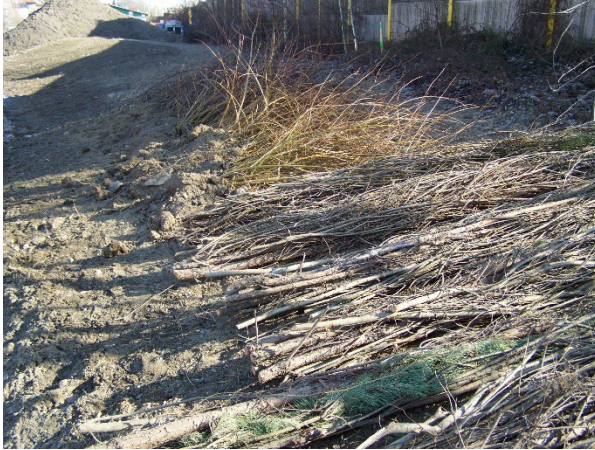
Foto 25: Die Gewinnung des Weidenmaterials für die Bauweise sollte aus ökologischen Gründen möglichst im Umfeld der Baustelle stattfinden. (Foto: A. Stowasser)
