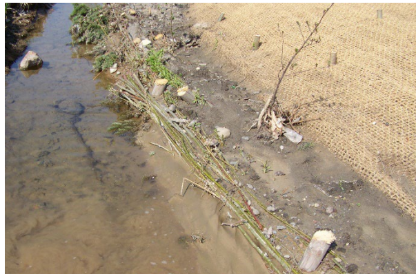
Foto 28: Anschließend erfolgt der Einbau der Gehölze. Die darüber befestigte Faschine hält die Bauweise am Böschungsfuß. (Foto: A. Stowasser)
