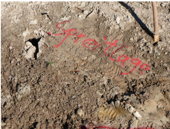
Foto 13: Vor dem Einbau der Spreitlage ist die Böschungfläche zu planieren. Die Äste der Spreitlage müssen glatt auf der Rohbodenfläche aufliegen können. (Foto: A. Stowasser)
