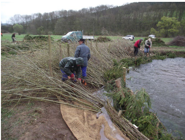
Foto 15: Alle Äste der Spreitlage sind mit dem dicken (basalen) Ende nach unten auf der Böschung einzubauen. Die unteren Enden müssen bis unter die Mittelwasserlinie reichen. (Foto: A. Stowasser)
