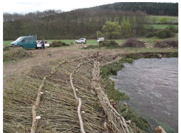
Foto 18: Die Pflöcke werden zum Andrücken der Astpackung auf die Böschung nochmals nachgeschlagen.
