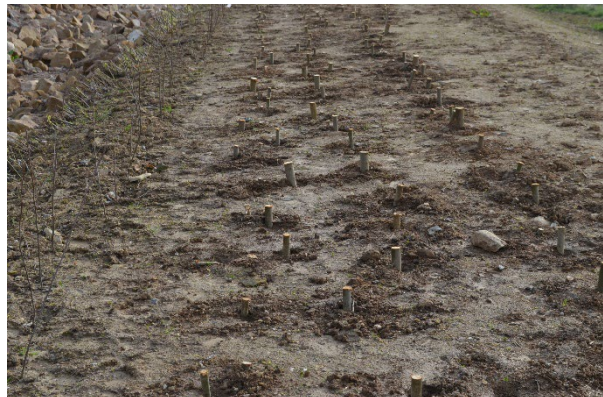
Foto 4: Steckhölzer werden in unterschiedlicher Neigung und auf der Böschung verteilt eingeschlagen. (Foto: A. Stowasser)
