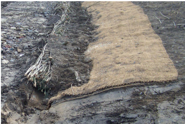
Foto 27: Die Böschungsschutzmatte ist zu unterst einzubauen, damit sie fest verankert ist und nicht herausgerissen werden kann. (Foto: A. Stowasser)
