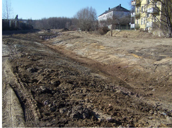
Foto 26: Bei der Profilierung des Bachbettes bzw. der Uferböschung sollte ein Graben für die Faschine vorgesehen werden und die Böschung möglichst flach gehalten werden. (Foto: A. Stowasser)
