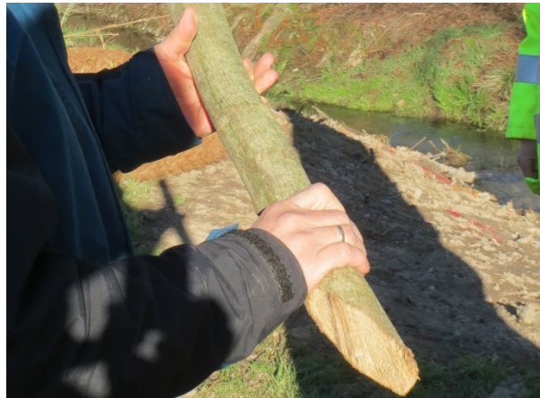
Foto 2: Bei Steckhölzern sollte immer auf die Wuchsrichtung geachtet werden. Am unteren Ende sind sie schräg anzusägen. (Foto: A. Stowasser)
