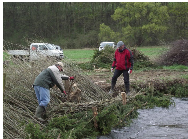
Foto 16: Die Äste müssen schließlich dicht aneinander gelegt die komplette Böschung bedecken. Mit der Lebendfaschine werden die unteren Astenden anschließend am Böschungsfuß festgeklemmt. (Foto: A. Stowasser)
