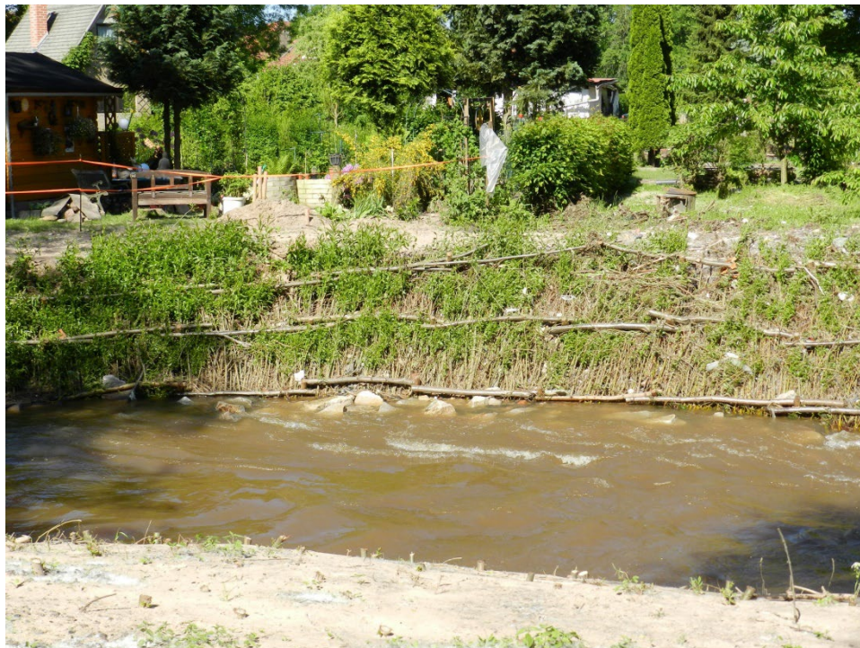
Abbildung 20: Zustand der Weidenspreitlage am 05.06.2013 9:00 Uhr nach Durchgang von 2 Hochwasserwellen am 31.05. und am 03.06.2013. (Quelle: M. Dittrich 2013)
