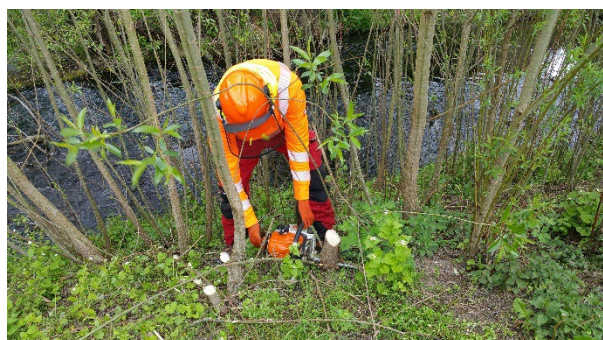
Foto 12: Bei Pflegemaßnahmen zur Bestandserziehung werden die stärksten Triebe gleichmäßig auf der Böschung verteilt erhalten. (Foto: A. Stowasser)
