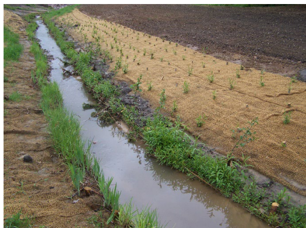
Foto 30: Die Bauweise bietet schon nach Fertigstellung einen Schutz für die Böschung, mit dem Anwachsen wird der Wirkungsgrad weiter erhöht. (Foto: A. Stowasser)
