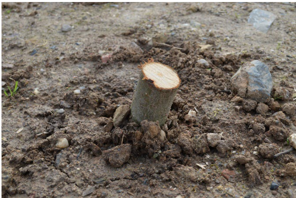
Foto 3: Der größte Teil der Steckhölzer ist in die Böschung einzubauen. Max. 5 cm sollten herauschauen, ggf. sind die oberen Enden noch einmal glatt abzusägen. (Foto: A. Stowasser)
