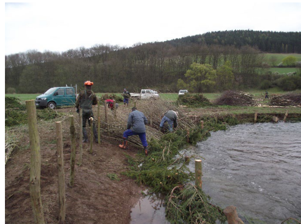
Foto 14: Zunächst sind die Befestigungspflöcke einzuschlagen. Dies kann mit Unterstützung des Baggers geschehen. (Foto: A. Stowasser)
