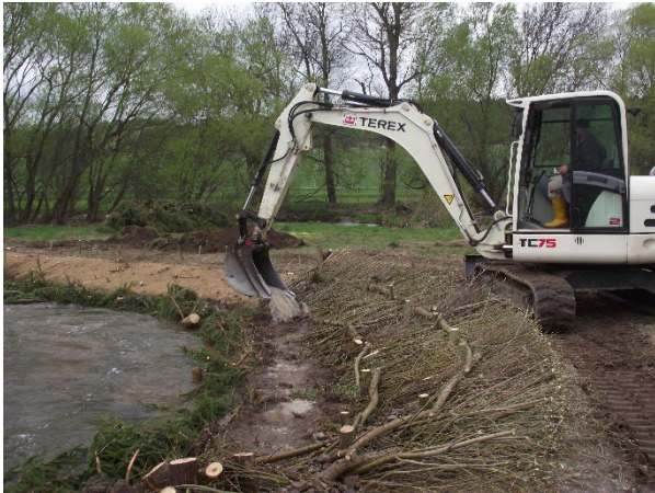
Foto 19: Durch leichte Übererdung und Einschlämmen des Substrats wird der Bodenkontakt für die Spreitlagenäste hergestellt und ein Austreiben ermöglicht. (Foto: A. Stowasser)
