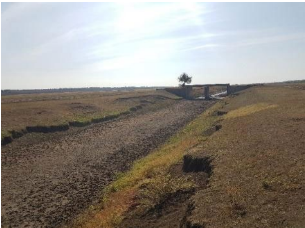
Abbildung 2: Begradigter Kanal des grenzüberschreitenden Flusses Kyrhyzh-Kytai. (der Fluss entspringt in Moldawien, der Hauptkanal liegt in der Ukraine). (Quelle: Grychulevych, 2019)
