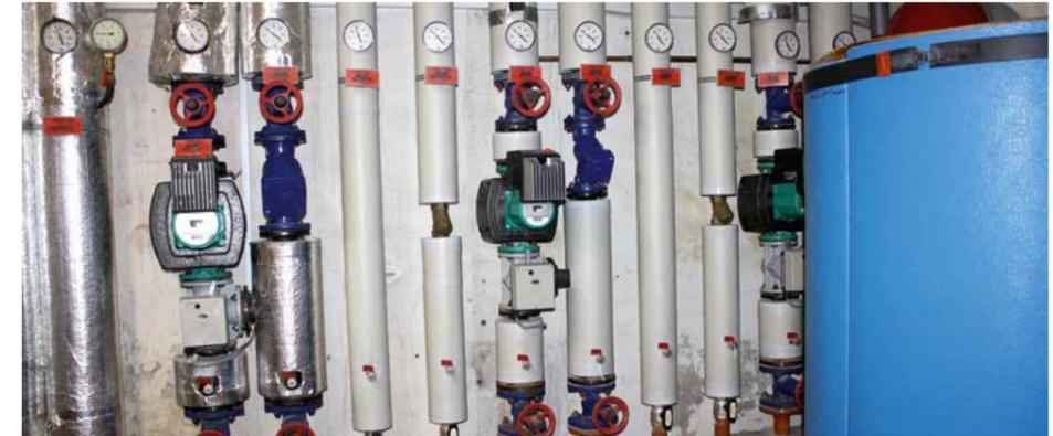
Foto: gedämmte Heizungsrohre, Florian Kliche
