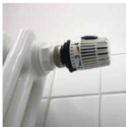
Hierunter wird das klassische Thermostatventil verstanden, das viele auch aus dem privaten Bereich kennen. Es lässt sich per Hand auf die entsprechenden Temperaturen einstellen. Idealerweise finden sich diese Thermostatventile in den Klassenräumen, da diese es ermöglichen, beim Lüften die Heizung abzudrehen. Häufig ist es sinnvoll, die Thermostatventile auch so zu begrenzen, dass es nicht möglich ist, die Heizung höher als auf Stufe drei einzustellen.
