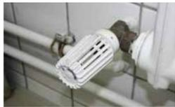
Ein Behördenventil lässt sich nicht einfach per Hand vom Nutzer einstellen. Für die korrekte Einstellung dieser Ventile ist ein Schlüssel notwendig, der i.d.R. beim Hausmeister zu finden ist. Idealerweise sind diese Thermostatventile in Eingangsbereichen, Flurbereichen, Treppenhäusern und Toiletten installiert.
