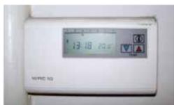
Vermeehrt kommen inzwischen auch Systeme zum Einsatz, die die Nutzerin oder der Nutzer nur noch bedingt beeinflussen kann. Dazu gehört die sogenannte Einzelraumregelung. Hier werden die Thermostatventile an den Heizkörpern per Computer gesteuert. Dort sind die Nutzungszeiten der Räume hinterlegt, in denen auf eine bestimmte Temperatur geheizt werden soll. Per Messfühler wird die Raumtemperatur ständig kontrolliert und bei Unterschreiten der Solltemperatur wird dann geheizt.
