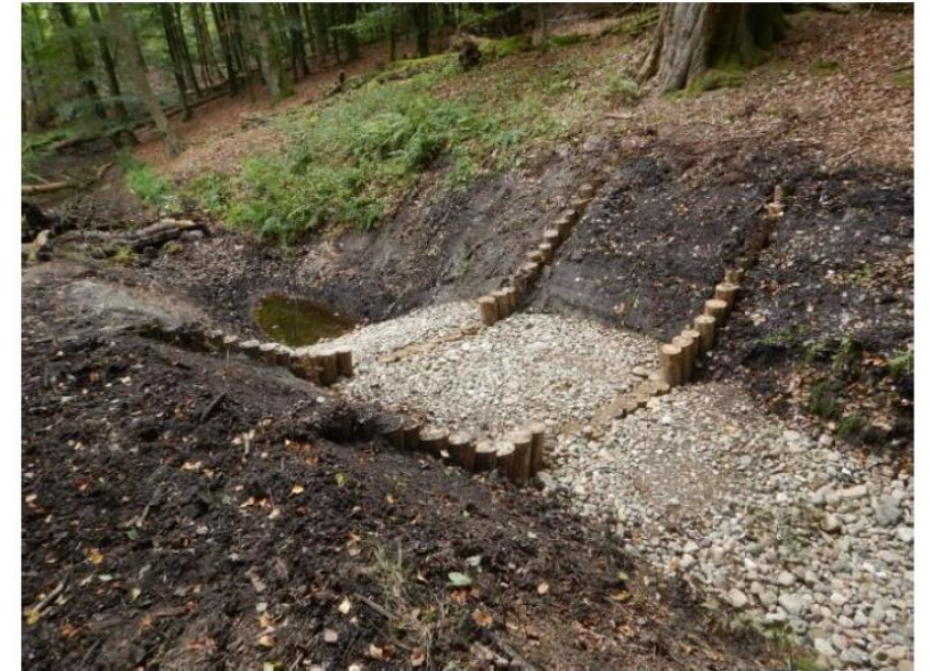
Beispiel Doppelpfahlreihe mit Dichtungskörper, Foto: biota
